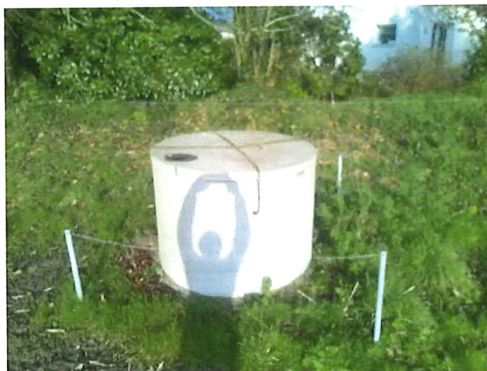
Figure 3 : protection de la tête de forage
